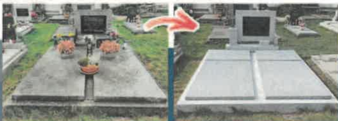
Ukázka realizace: broušení teracových ráků a výměna desek za žulové.
